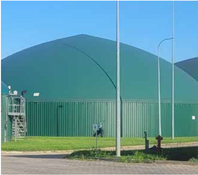
● Zbiornik fermentacyjny w biogazowni w Giżach
