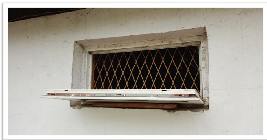
Fot. Zabezpieczenie okna przed wybiciem po wewnętrznej stronie boku
