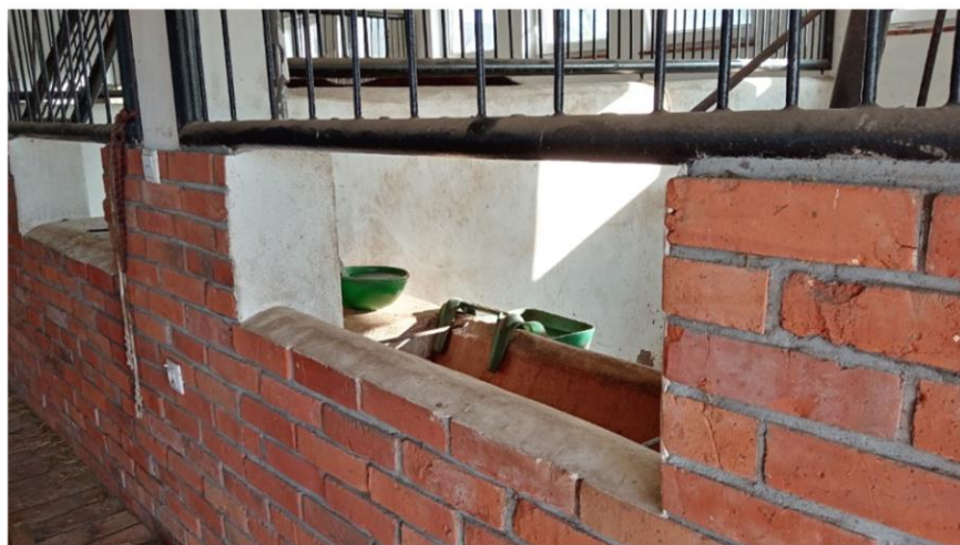
Fot. Otwór w ścianie frontowej boksu umożliwiający karmienie koni bez konieczności wchodzenia do boksu.
